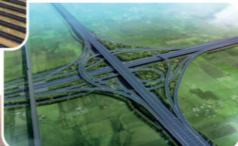
G107工程施工总承包项目
