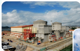
大亚湾核电站项目
