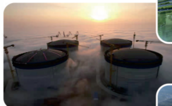
龙口南山LNG项目
