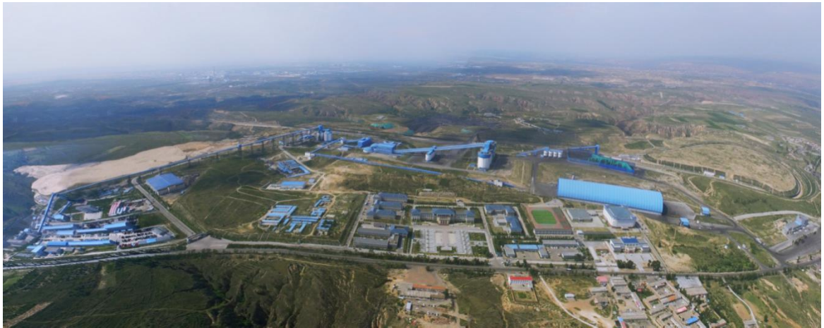
荣获改革开放三十年经典工程的不连沟矿井和选煤厂全景
