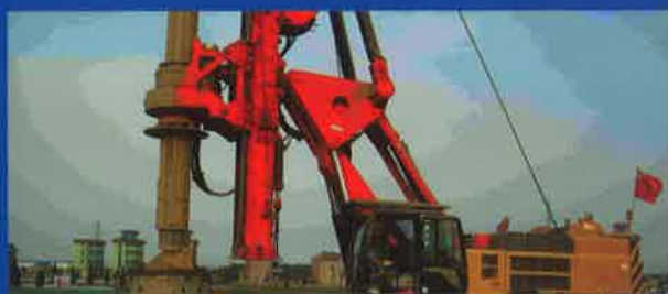
大连东港E15、E16、E19 地块项目四季上东项目施工
