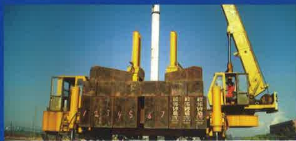
沈阳中海城项目静压管桩项目施工
