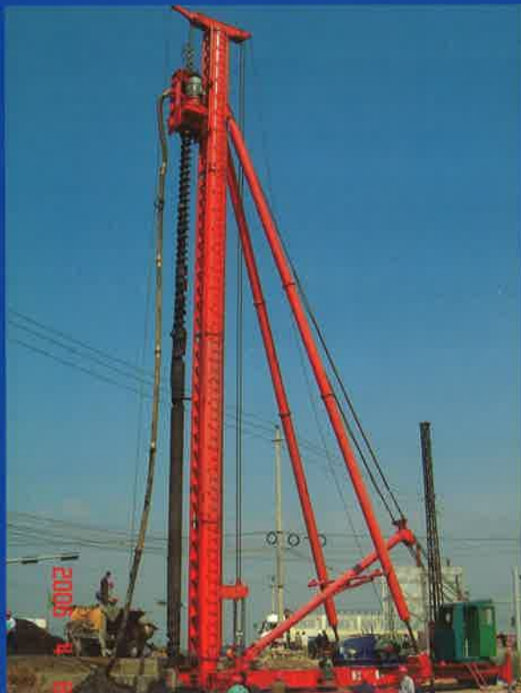
沈阳万科翡翠之光CFG地基处理工程施工
